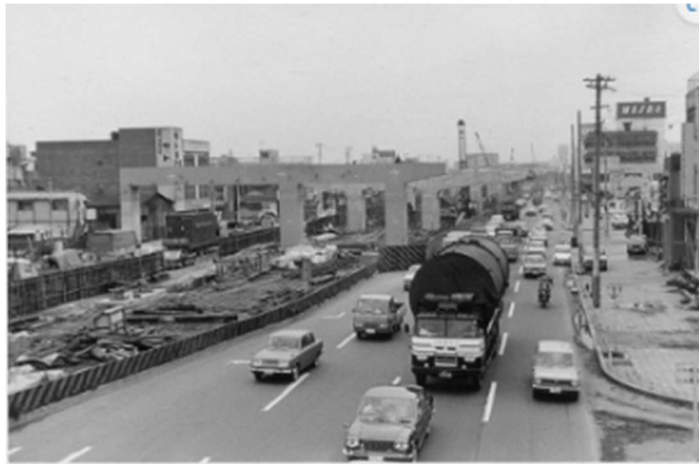
資料(2) しゅとこうそくどうろ 首都高速道路の建設 すす が進む国道15号（ けんせつ 神奈川2丁目、1965年）
